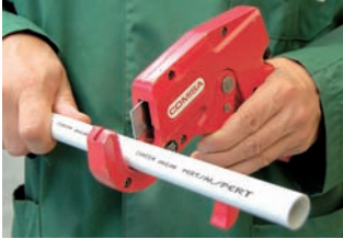
1. Ablängen des Rohres
