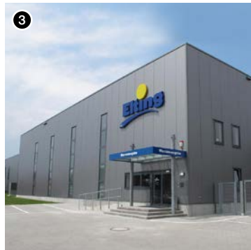
3. Elting Lagerhalle in Deutschland. Fot. © elting.com
