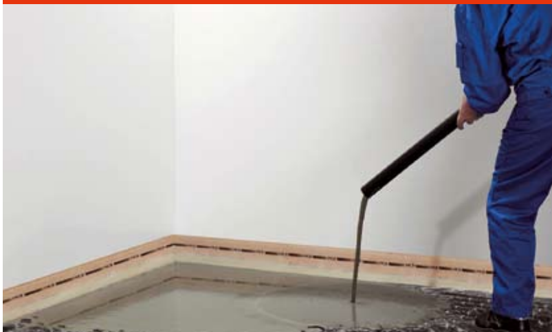
Abb. 32: Einbringen der Füll- und Vergussmasse
