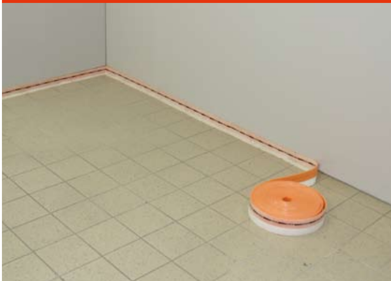
Abb. 26 Randdämmstreifen verlegen
