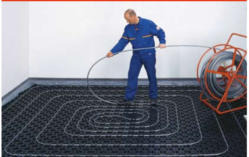
Abb. 9: Vitaset System-Heizrohr auf Noppenelemente verlegen
