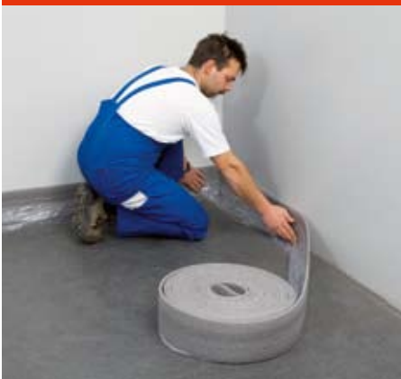
Abb. 14: Randdämmstreifen verlegen
