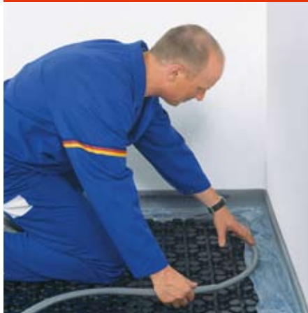
Abb. 8: PE-Rundprofil verlegen
