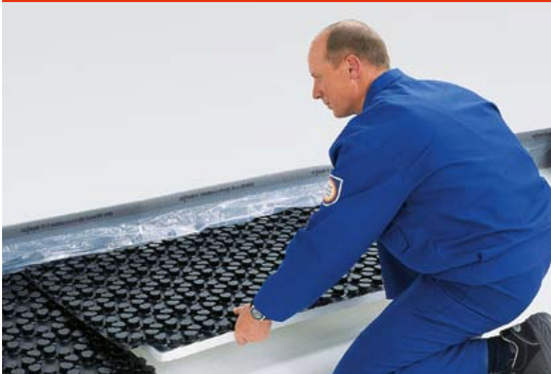
Abb. 5: Elemente formschlüssig verlegen
