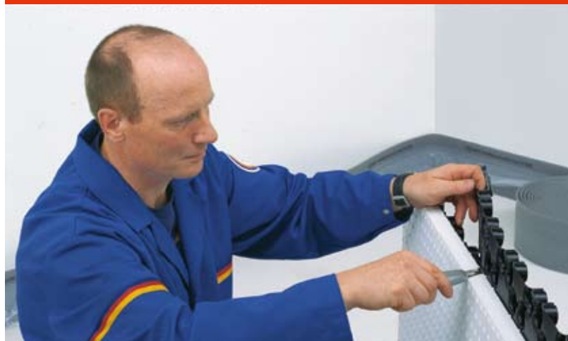
Abb. 3: Folienüberstand des Noppenelements abschneiden
