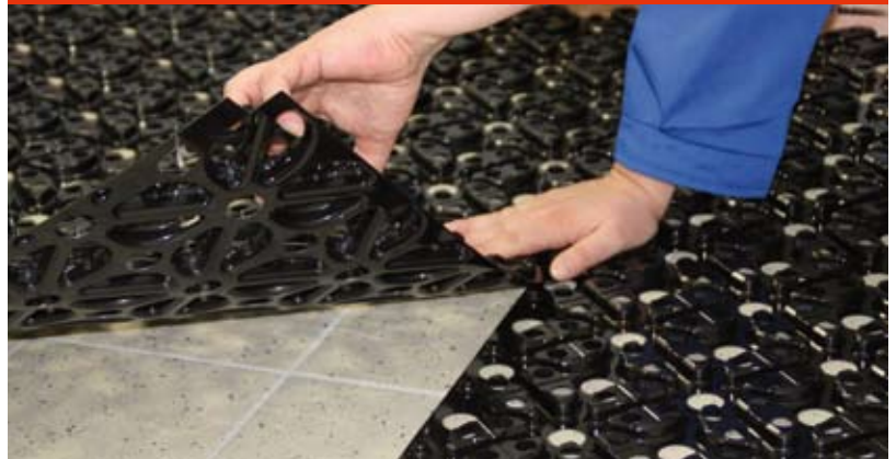
Abb. 29: Systemplatten formschlüssig verlegen
