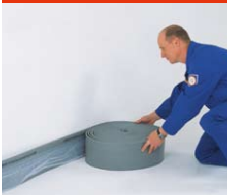
Abb. 2: Randdämmstreifen verlegen
