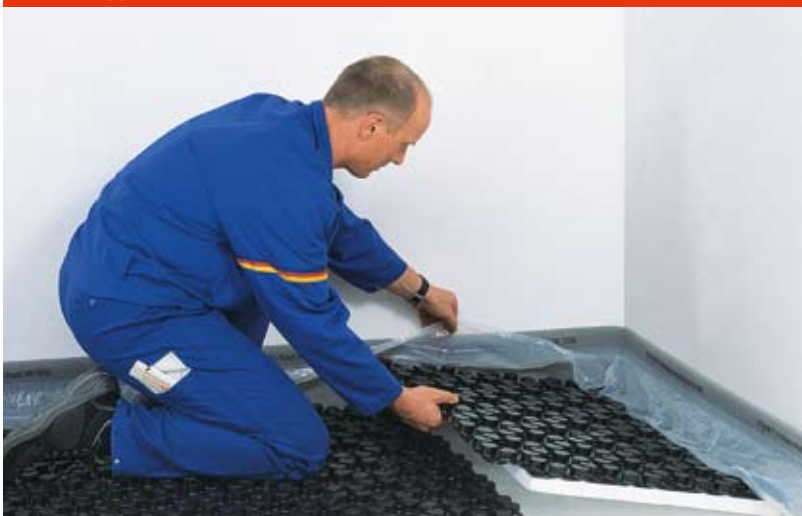
Abb. 6: Noppenelement auf Maß schneiden
