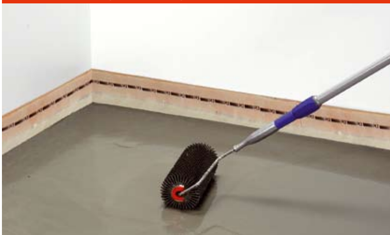
Abb. 33: Nachbehandlung der Füll- und Vergussmasse
