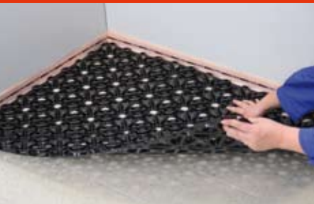
Abb. 28: Erste Systemplatte anlegen
