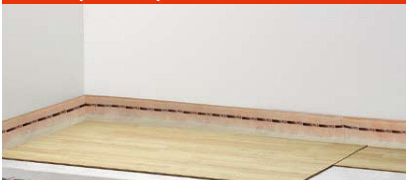
Abb. 34: Aufbringen des Bodenbelags
